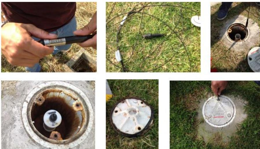
Figura3 Instalación de los sensores (freatímetros).
